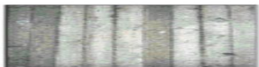
Variazioni di colore sulla superficie in evidenza poche ore dopo la rimozione delle casseforme
